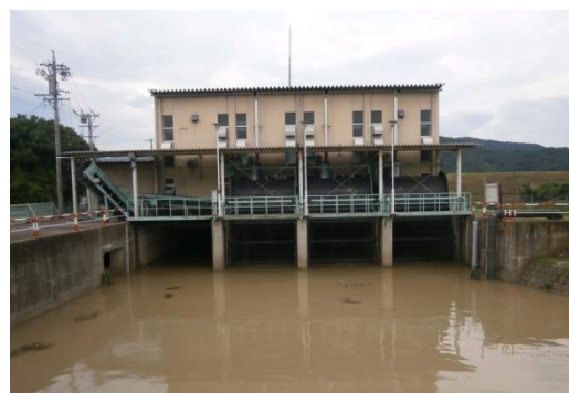
小森第一排水機場全景
